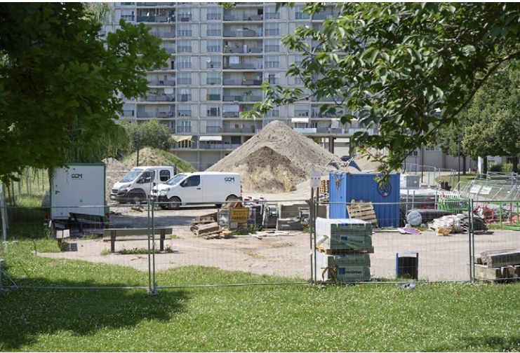
17 juin 2025 – Travaux sur la parcelle
