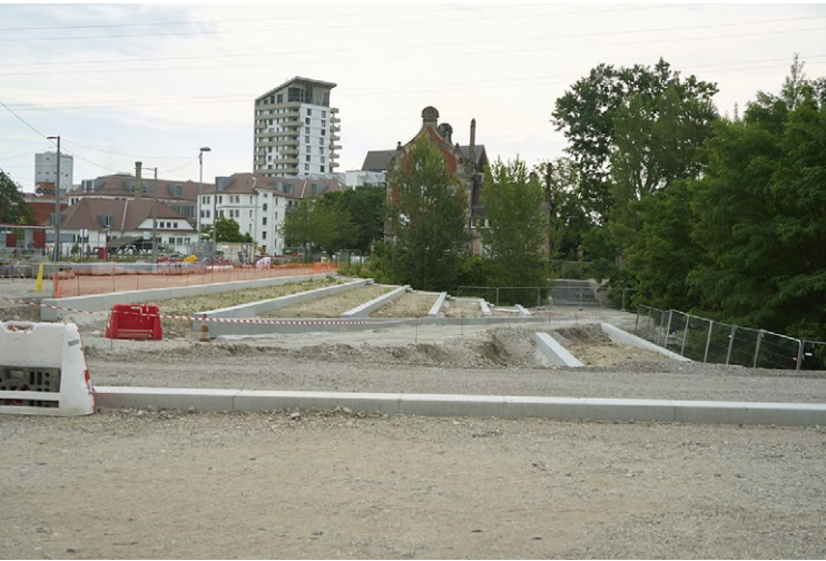
15 juin 2025 - Parcelle mise en chantier pour la création d'un parc
